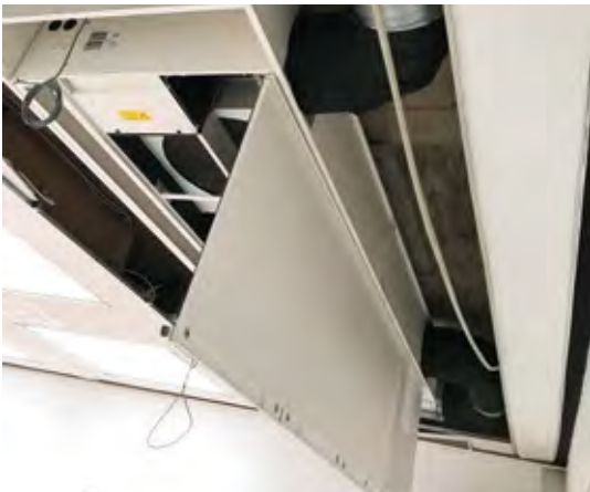
Abb. 4.11: Einhängen des Geräts in die zuvor installierte Zarge und rückseitiger Anschluss der Luftkanäle.
