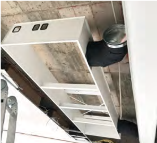
Abb. 4.9: Installation der Zarge mit etwas Abstand vom rückliegenden Unterzug zum seitlichen Verspringen mit 90°-Bögen.
