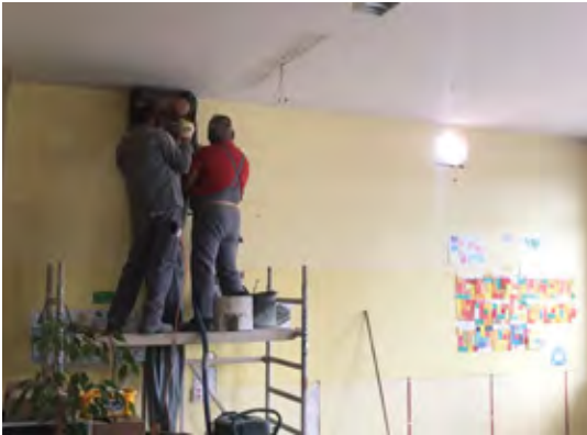
Abb. 4.18: Kernbohrungen für die Durchführung der Luftkanäle für Fort- und Außenluft direkt durch die angrenzende Außenwand.
