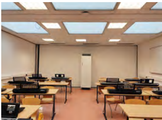
Abb. 4.4: Fensterloser Musikraum mit Lichtkuppeln und vorhandener abgehängter Decke (vor Sanierung).
