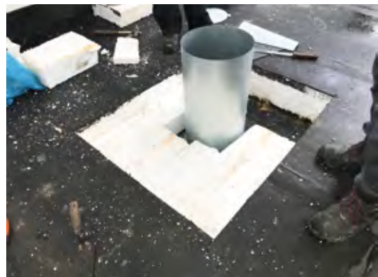
Abb. 4.8: Durch Decke geführter Luftkanal und anschließende Abdichtung und Wiederherstellung der Dampfsperre.
