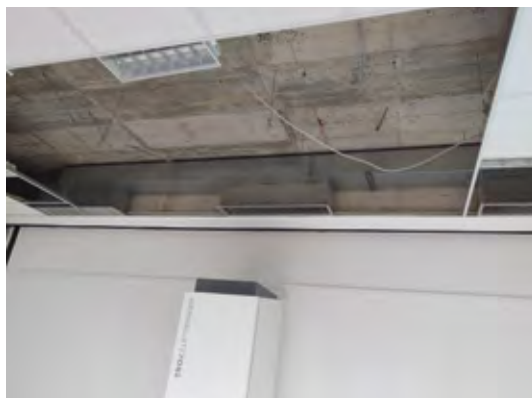
Abb. 4.5: Lokaler Rückbau der vorhandenen Systemdecke an der für das Deckenlüftungsgerät vorgesehenen Position und Freilegen der Luftkanäle der bestehenden, nicht funktionierenden Grundlüftung.
