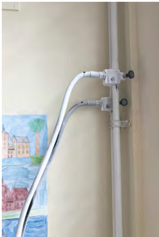
Abb. 4.21: Einfrieren der Warmwasserleitungen während des hydraulischen Anschlusses des Deckenlüftungsgeräts in den Heizkreis.
