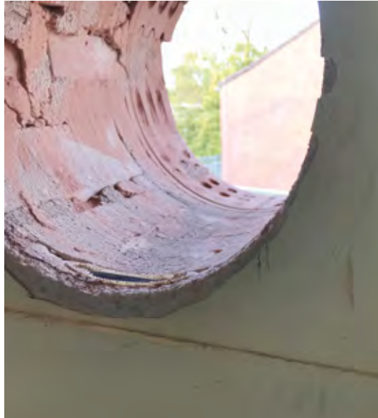
Abb. 3.5: Kernbohrung zur Durchführung von Lüftungskanälen durch das Mauerwerk.
