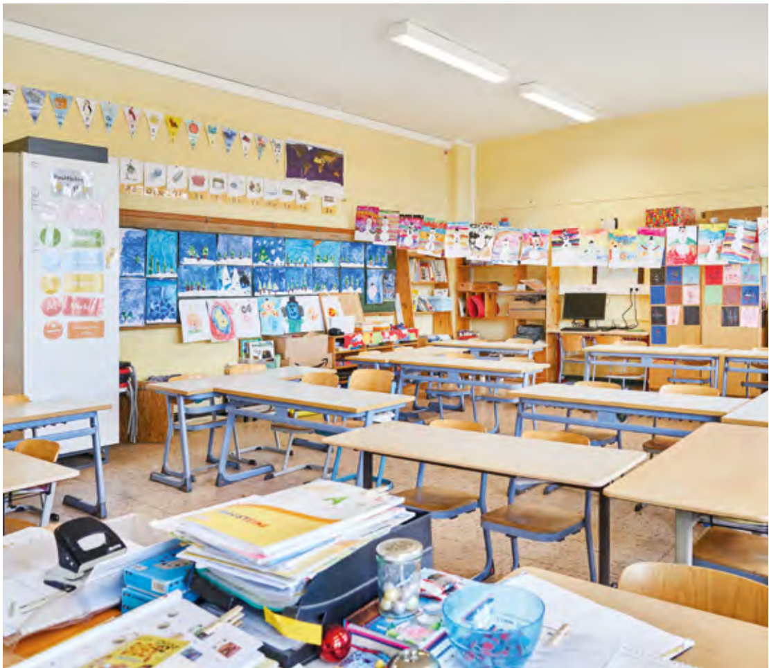
Abb. 3.1: Oft ist die Decke die einzig freie nutzbare Fläche im Klassenraum und Standlüftungsgeräte oder Luftreinigung können nur mit viel Mühe untergebracht werden. Deckenlüftungsgeräte können dieses Problem lösen.
